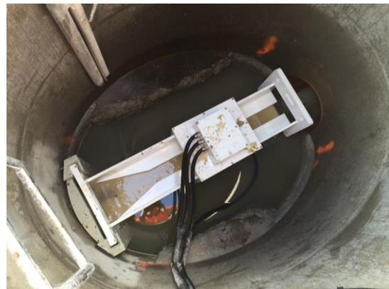
Beispiel Einbau im runden Kanalisationsschacht
